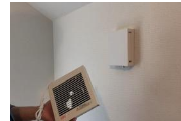
図 13 給気口とパイプ用ファン
