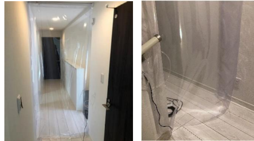
図10 ビニールの間仕切り
